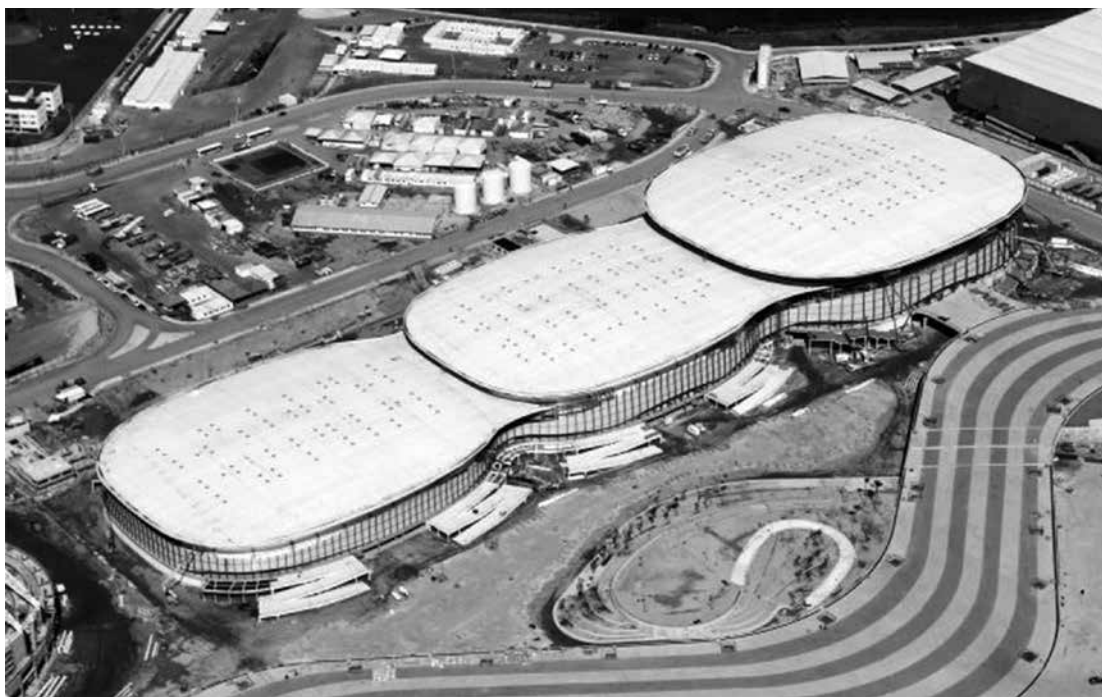
As obras para os Jogos Olímpicos do Rio continuam aceleradas e 8 arenas já foram concluídas
